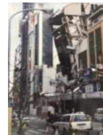
▲阪神淡路大震災による被災建築物
