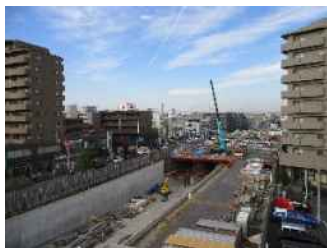
▲放射35号線 (平和台駅付近の立体交差点)
