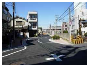
▲拡幅後の路線（北町）
