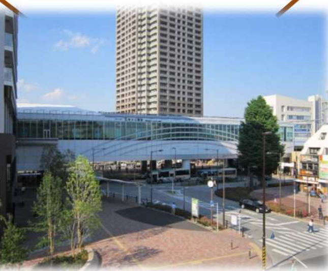
▲連続立体交差化の完了した石神井公園駅
