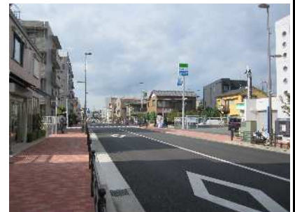
無電柱化された道路 (補助132号線)
