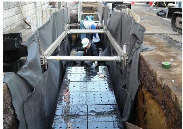
雨水貯留浸透施設設置工事
