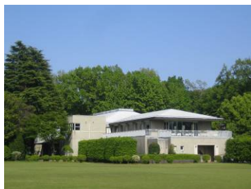
（クラブハウス外観）
