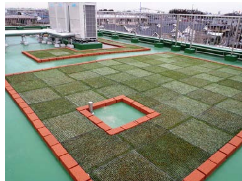
(既存製品による屋上緑化の事例)
