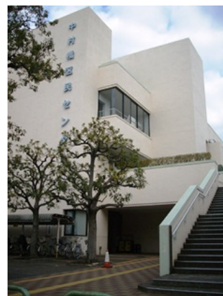
【中村橋福祉ケアセンター (中村橋区民センター内)】
