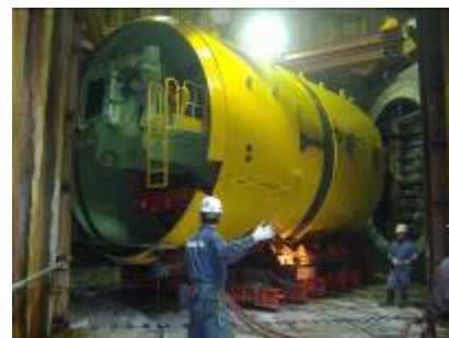
工事の様子(豊中通り地下)
