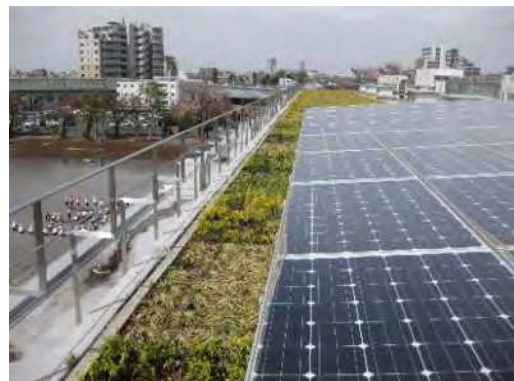
小学校への太陽光パネルの設置
