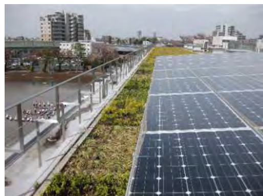
小学校への太陽光パネルの設置
