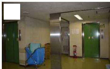
エレベータ4号機(B1F-6F) 5号機(B1F-1F)
