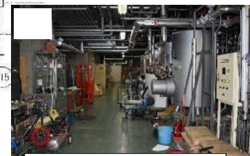
ボイラー蒸気配管等
