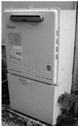
写真2 潜熱回収型高効率給湯器の例
