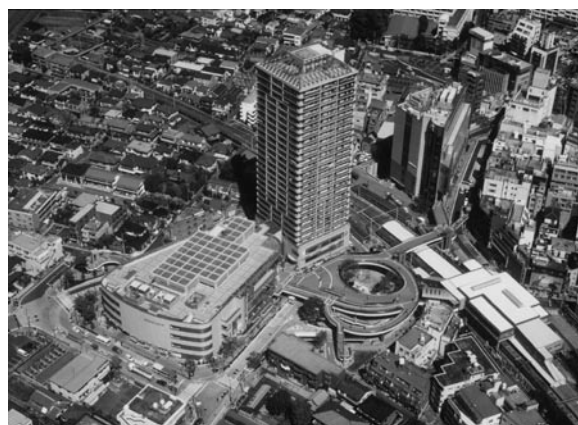
写真2 大泉学園駅（整備後）
