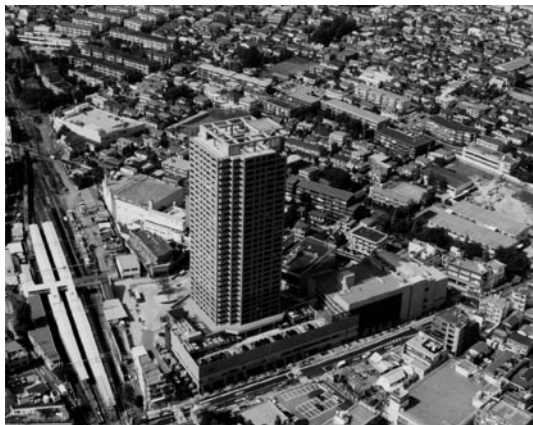
写真1 石神井公園駅（整備後）
