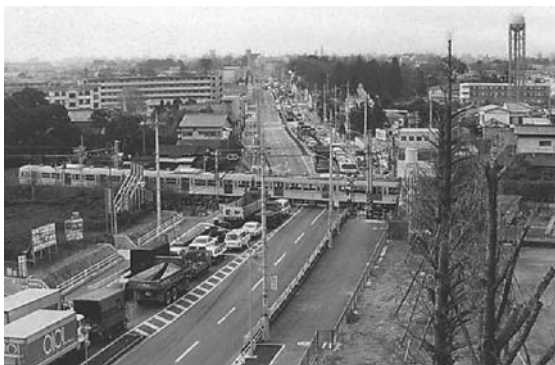
写真1 連続立体交差事業（西武池袋線）整備前
