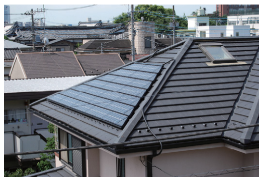
太陽光発電設備
