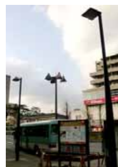
左端：水銀灯街路灯 右端：LED 街路灯
