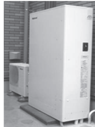
自然冷媒ヒートポンプ給湯器（エコキュート）
