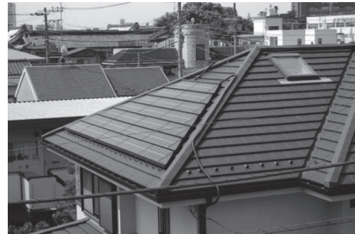
太陽光発電設備
