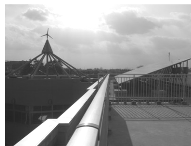
光和小学校の太陽光発電・風力発電
