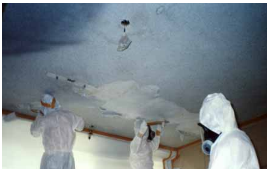
アスベスト除去工事の様子
