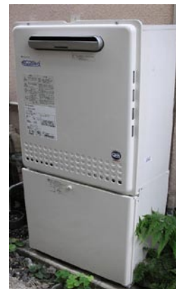
写真2 潜熱回収型高効率給湯器の例
