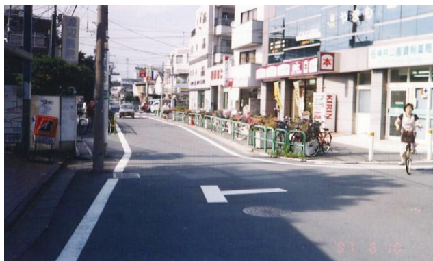
写真1 補助132号線（石神井町2丁目）整備前
