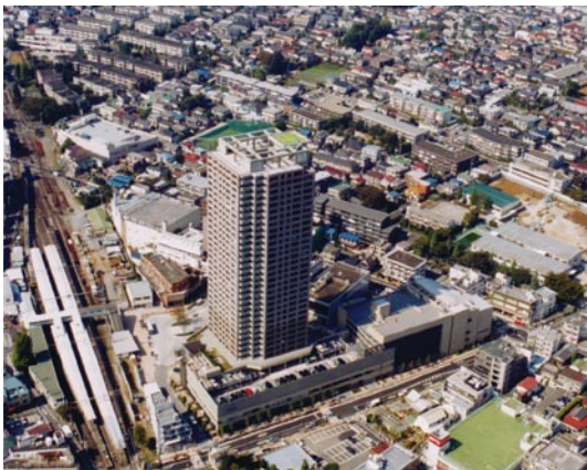
写真1 石神井公園駅（整備後）
