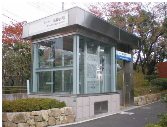
写真1 区内の駅に設置されているエレベーター
