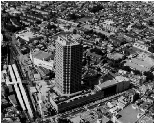
写真1 石神井公園駅（整備後）
