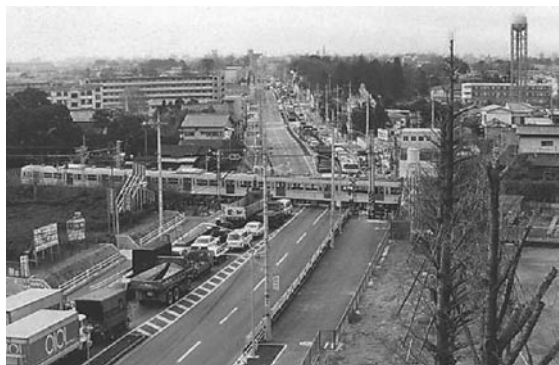
写真1 連続立体交差事業（西武池袋線）整備前
