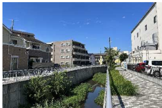
白子川の護岸整備済み区間（前田橋付近）
