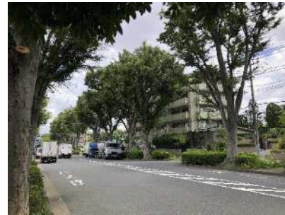
補助 233 号線整備済み区間（大泉学園町八丁目）
