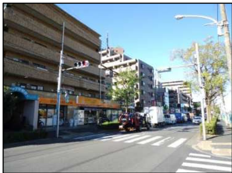
③放射 35 号線沿道 共同住宅
