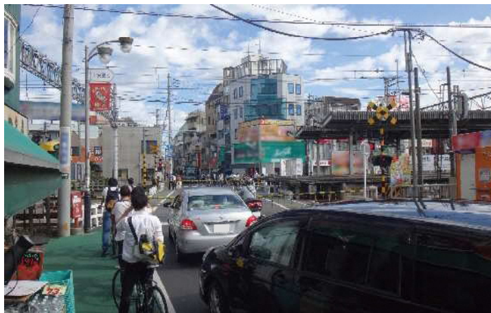
踏切の状況（上石神井第1号踏切道）
