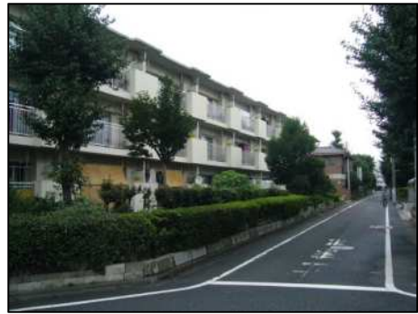
住宅地区 B 地区(北町六丁目)
