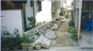
倒壊したブロック塀(資料写真)
