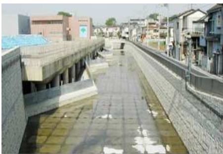
白子川比丘尼橋下流調節池（河川） （写真出典：区ホームページ）
