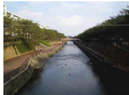
石神井川緩傾斜護岸 (写真出典：練馬区みどりの基本計画)
