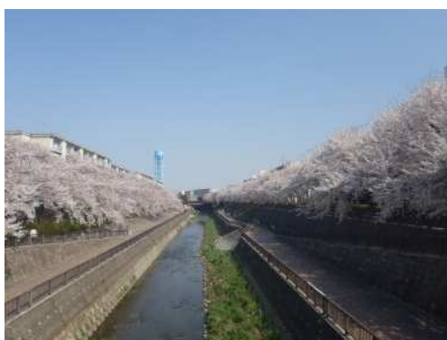
石神井川の緩傾斜護岸
