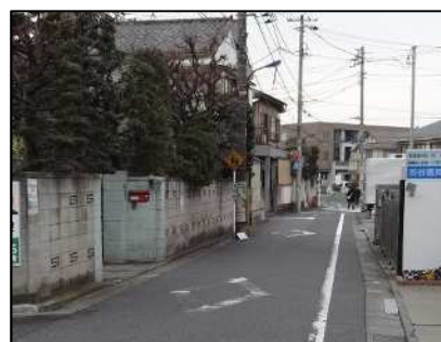
ブロック塀（事例）
