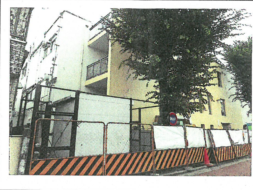
写真No. 2 上石神井出張所 現況調査 北東側外観
