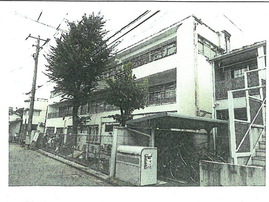
写真No. 3 上石神井出張所 現況調査 南東側外観
