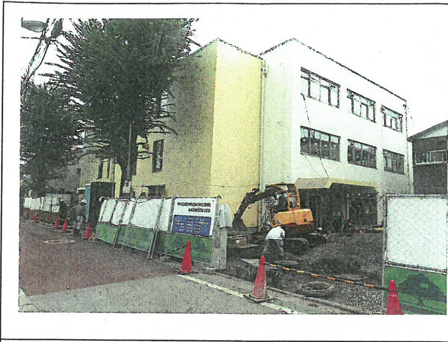
写真No. 1 上石神井出張所 現況調査 北西側外観
