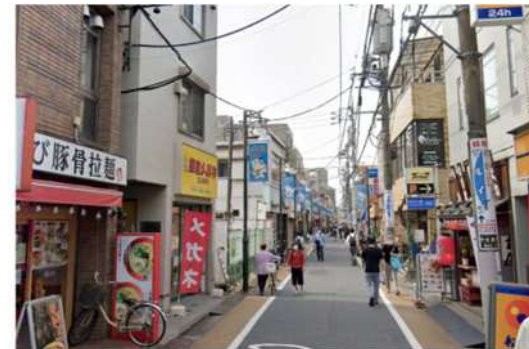
中杉通（補助第133号線 整備後）
