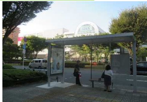
令和元年 8月 完成
