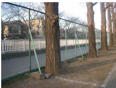
3 外周フェンス
