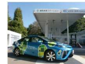
練馬区谷原の水素ステーション
