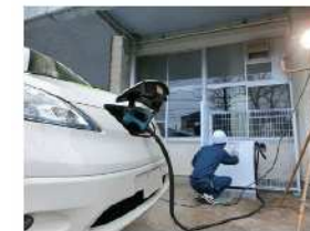
外部電力供給設備による給電の様子
