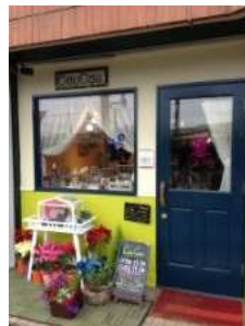
空き店舗を活用した 店舗改修
