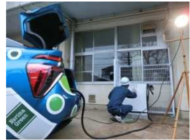
燃料電池自動車を活用し、 災害時の電源を確保します
