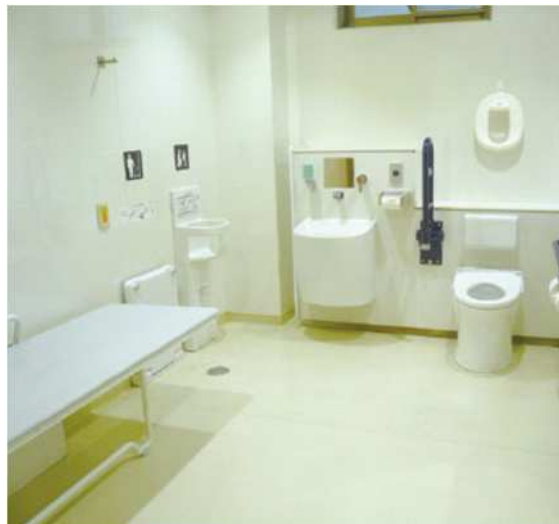
大型ベッド、オストメイト設備を設けた だれでもトイレの設置（図書館）
