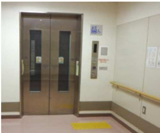
写真：区立施設の改修事例 ガラス窓付きエレベーターを設置（集会所）
