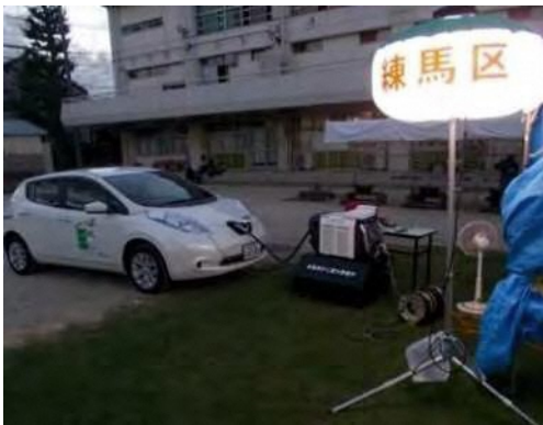
EVによる給電の様子
