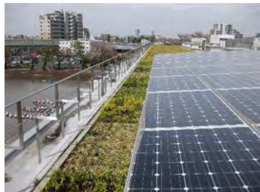
小学校への太陽光パネルの設置
