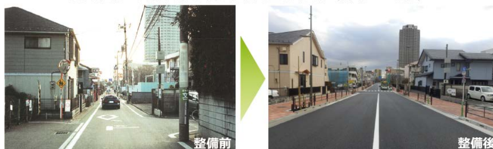
無電柱化により防災性や快適性が向上した道路（補助132号線）
