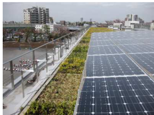
小学校への太陽光パネルの設置
