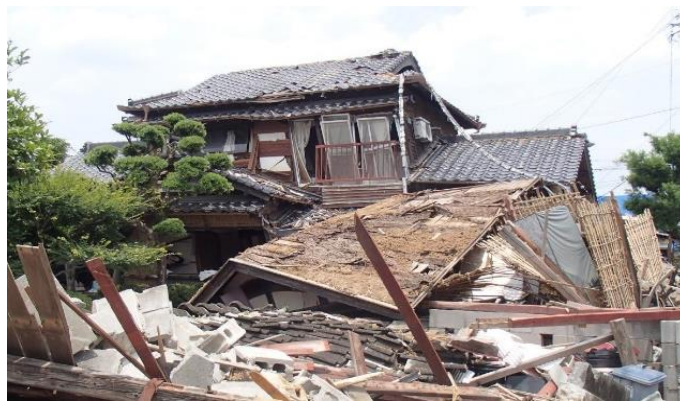
熊本地震の被害
