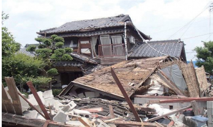
熊本地震の被害
