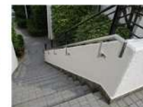
手すりを設置しました。
