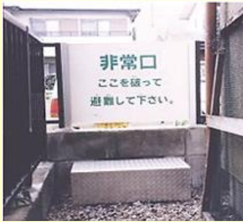
蹴破り戸を設置した事例
