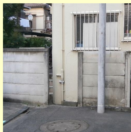
ブロック塀を撤去して通路を確保した事例
