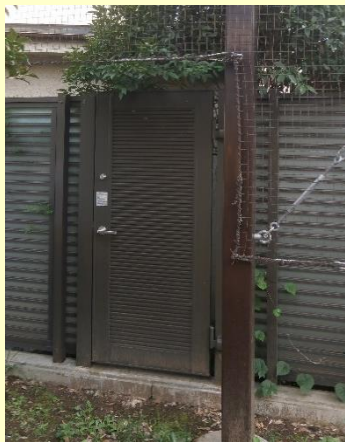
門扉を設置した事例
