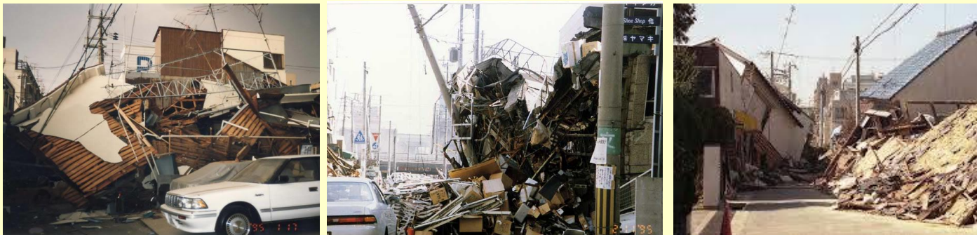
阪神・淡路大震災により建物が倒壊して道路が塞がってしまった事例
