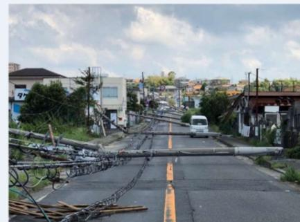
平成30年9月の台風21号による電柱の倒壊（出典：国土交通省HP）
