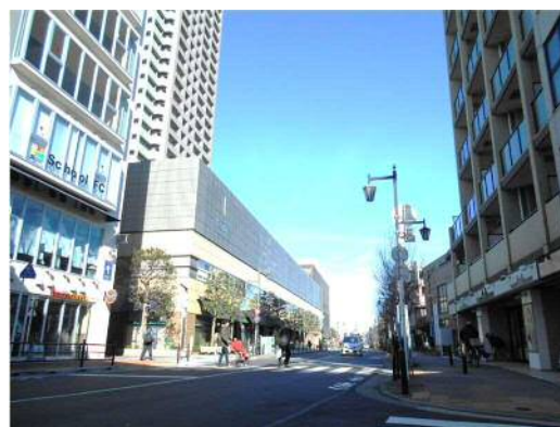
▲石神井公園駅北口地区（無電柱化済み）
