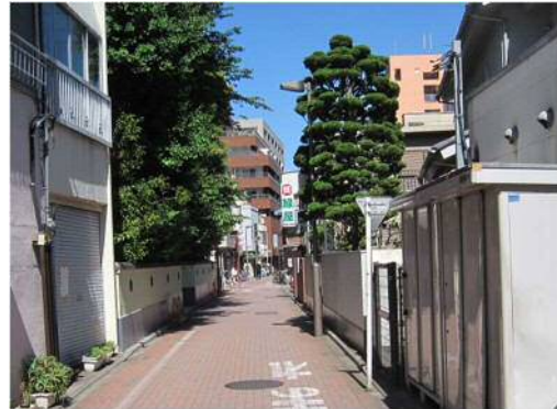
▲練馬駅南口地区（無電柱化済み）
