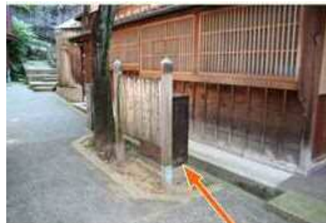
地上機器設置場所
