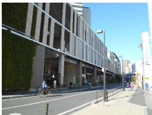
▲大泉学園駅北口地区（無電柱化済み）
