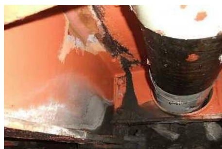
【主桁端部の腐食】
