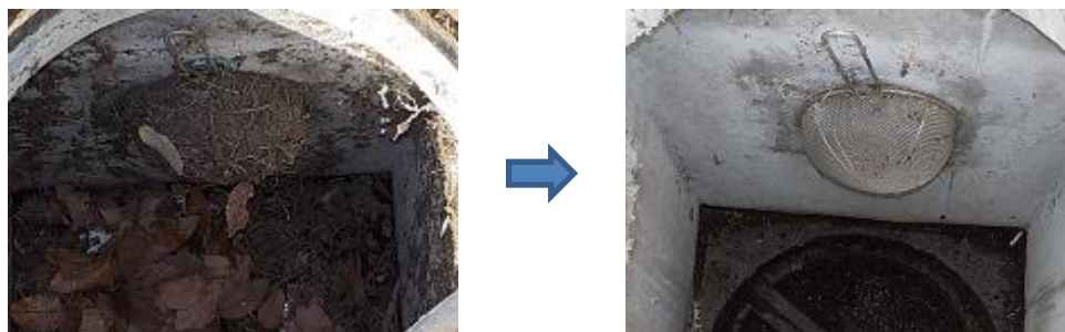
浸透ますおよび管口フィルターの清掃
