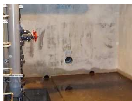
(3) - ② 管路等の目視点検
