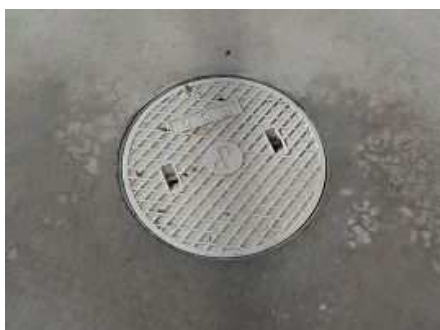
(1) - ① 蓋の目視点検 (破損状況)
