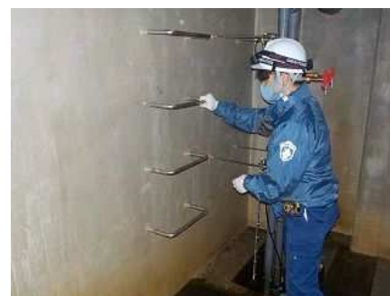
(3) - ④ 昇降設備の点検
