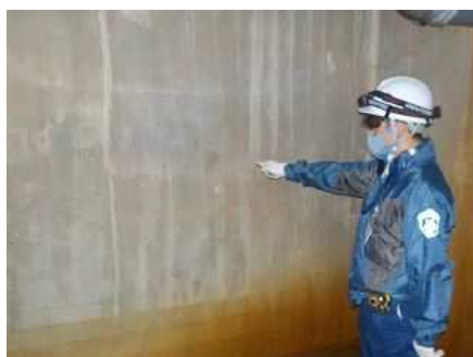
(3) - ③ 壁面等の目視確認
