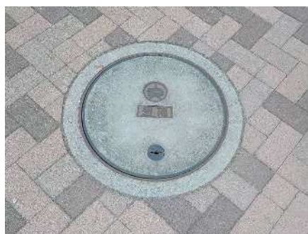
(1) - ① 蓋の目視点検 (破損状況)
