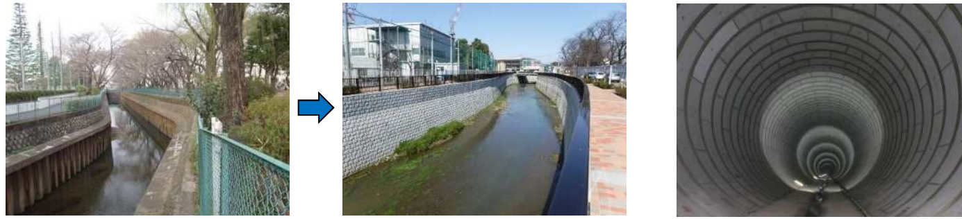
河川改修 (石神井川 松之木橋付近)
