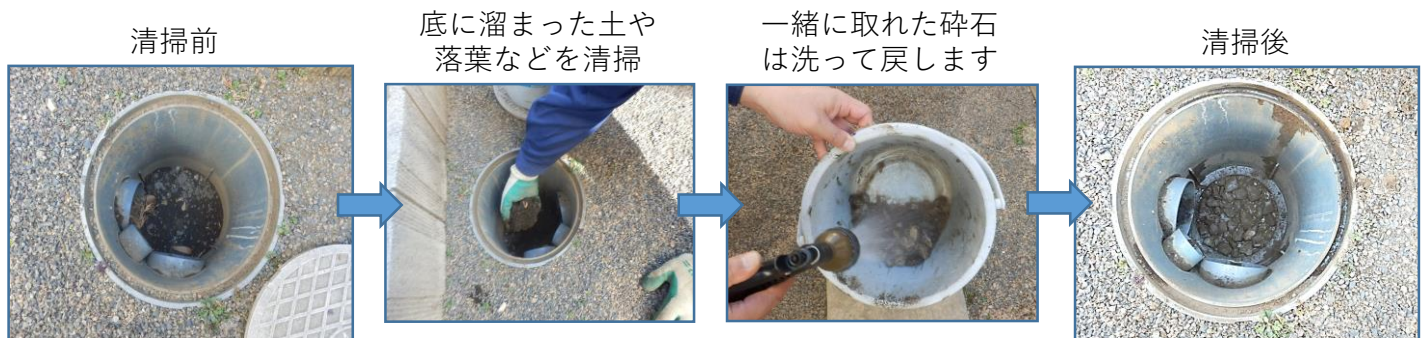
浸透ますの清掃例
