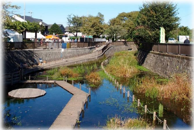
一級河川白子川10kmの起点はここから始まり、多くの湧き水を集めて新河岸川へ。上流は動植物が豊かで地域の憩いの場です。
