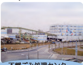
不燃ごみ処理センター
