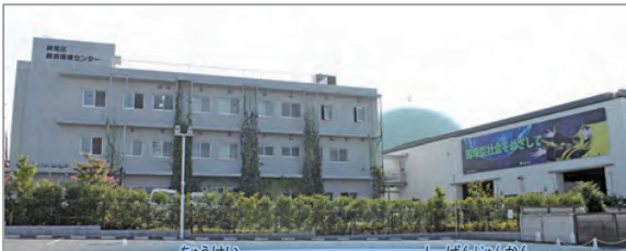
不燃ごみ中継施設 (練馬区資源循環センター)
