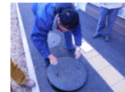
①マンホールを開ける
